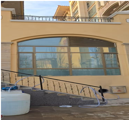
拟建安装锅炉的锅炉间
